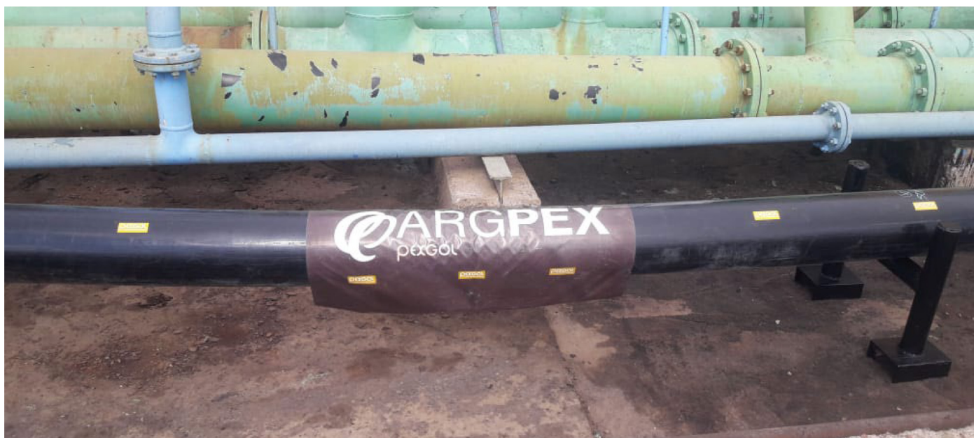
Монтаж труб Pexgol на установке подготовки пластовой воды.
