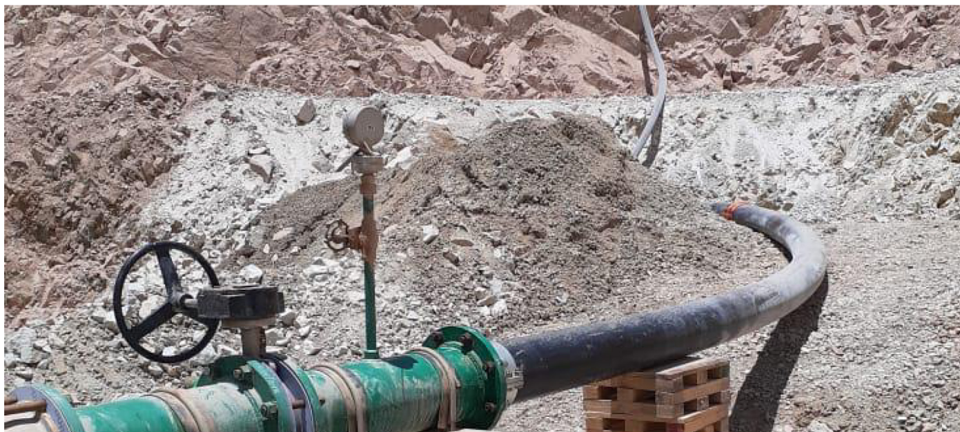
Установка дренажной системы на карьере.
