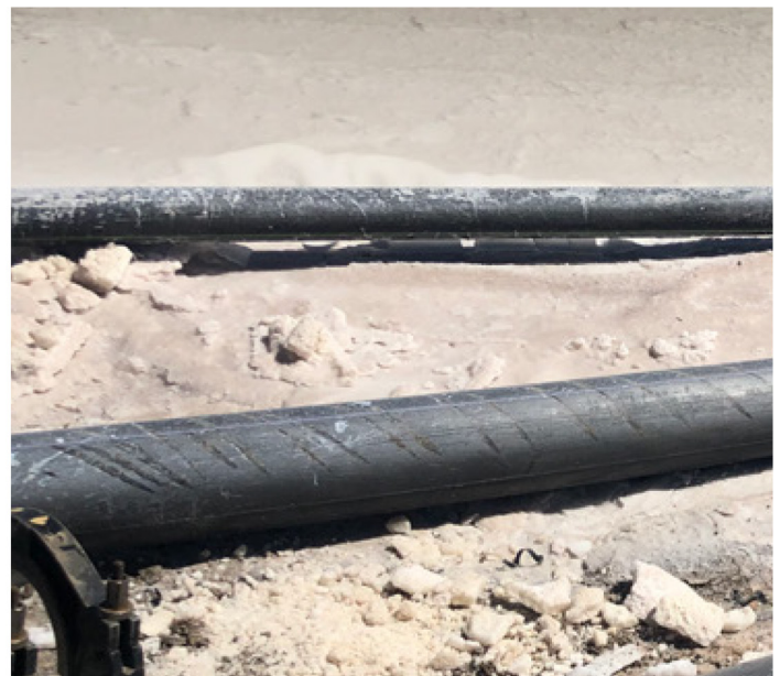
Очистка труб из ПЭВП требует серьезных физических усилий от операторов, поскольку им нужно наносить сильные удары для отделения осадка, поэтому техобслуживание занимает больше времени.
