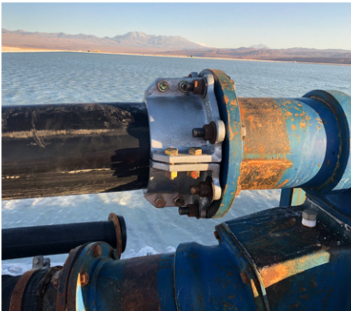
Acople bridado conectado a la bomba.
