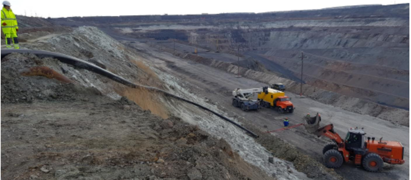
Instalación vertical de tuberías Pexgol sobre rocas para desagüe minero.
