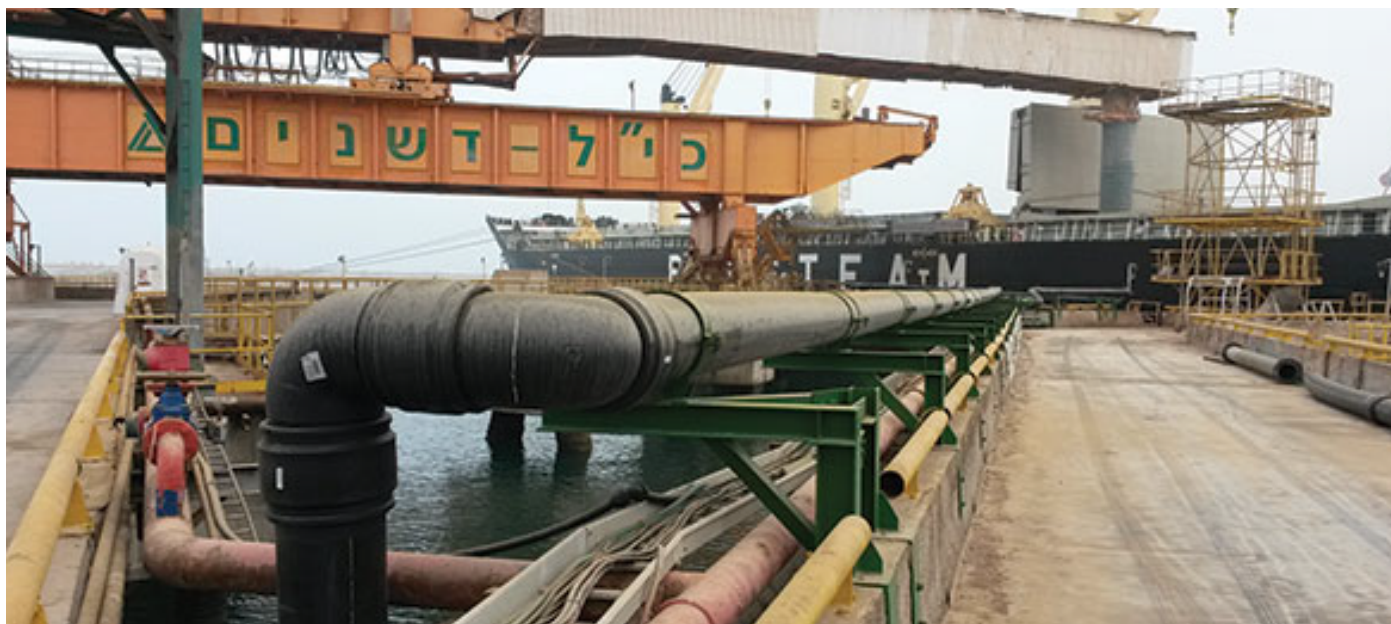
Установка трубы Pexgol поверх устаревшей стальной трубы
