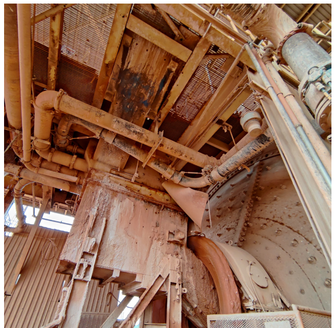
Tubería Pexgol instalada en el sitio.
