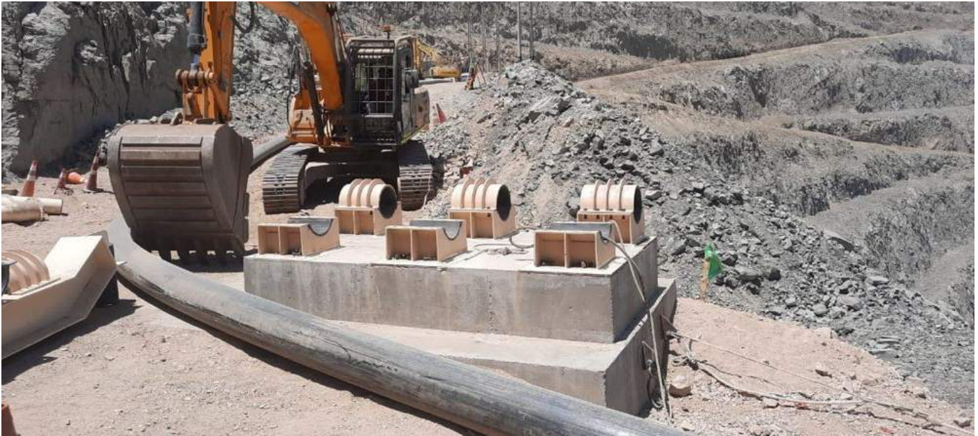
Instalación de tubería Pexgol para drenaje de mina a cielo abierto.
