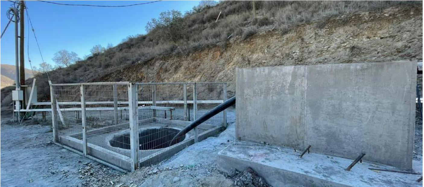
Instalación de tubería Pexgol a través de una chimenea para aire comprimido.
