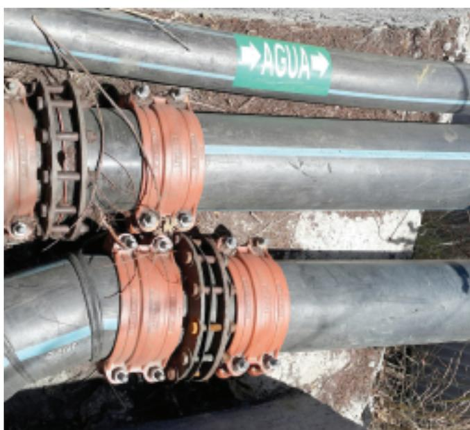
Термоплавкое соединение ПЭНД с выпуском, плюс ответный фланец и усиленные муфты Victaulic 995
