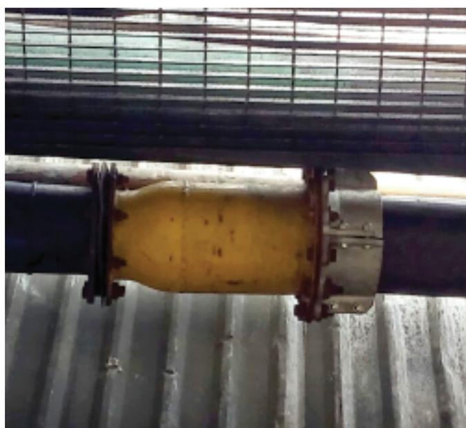
Адаптация трубы Pexgol 10 дюймов с существующим стальным переходником с покрытием 10 x 8 дюймов
