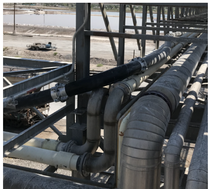
Gracias a la flexibilidad de las tuberías Pexgol en muchas secciones se han ahorrado codos prefabricados.
